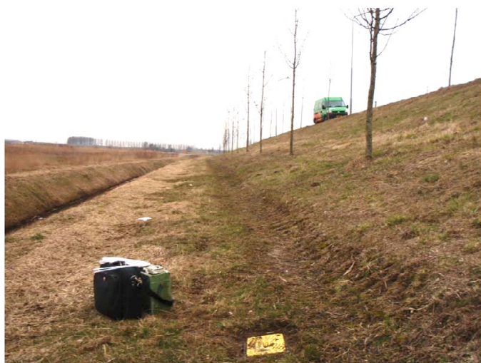
Foto: Bomen op isolerende constructie vormen risico voor de isolerende voorziening.
