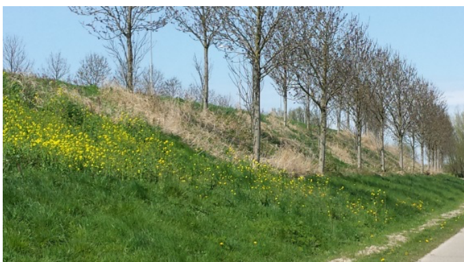
Foto: Bomen op talud kunnen op termijn leiden tot schade.
