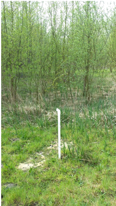
Foto: Monitoringsvoorziening kwetsbaar: peilbuis zonder mantelbuis.
