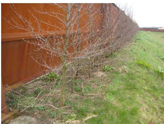
Foto: Jonge aanplant die op termijn mogelijk tot schade kan leiden.
